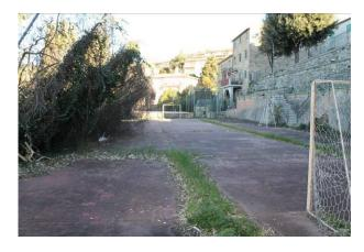
I giunti di dilatazione si sono talmente aperti che, al loro interno, si è depositato molto terreno, dando origine a una rigogliosa vegetazione.
